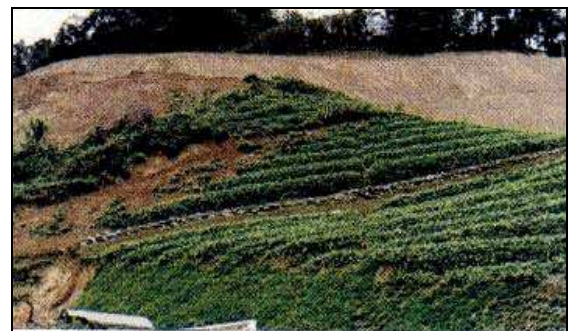
Gambar 8.2: Penanaman pokok secara alur melintang sangat penting untuk mengurangkan kadar hakisan permukaan cerun.
