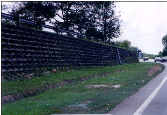
Gambar 8.4: Pemasangan 'weephole wall' sangat berkesan menstabilkan cerun yang dipotong ( Sg. Tukang – 14 November 2003)
