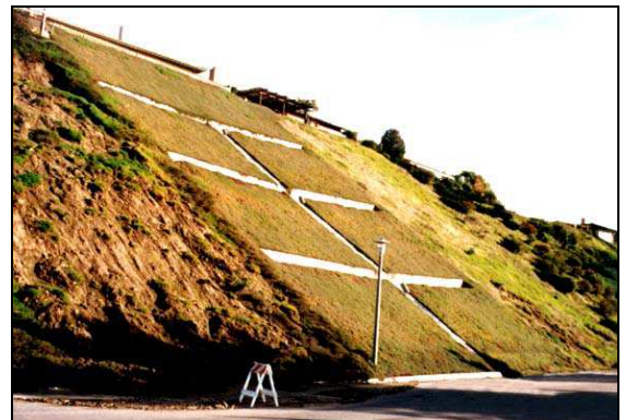
Gambar 8.7: Longkang bercantum dengan satu alur keluar sangat efektif untuk menjamin kestabilan cerun.
